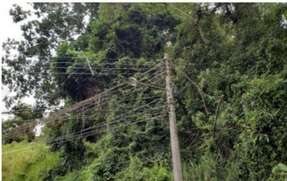
**Figura 06** – Área com vegetação de grande porte, capaz de interferir na rede de baixa tensão, em caso de queda.
