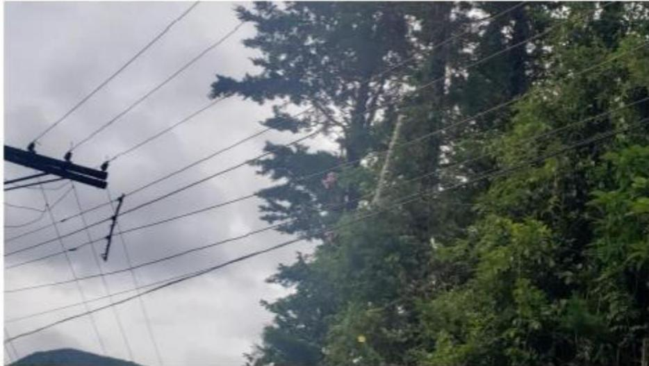
Cabeamento com emendas, tensionamento não uniforme, e espaçadores mal afixados
