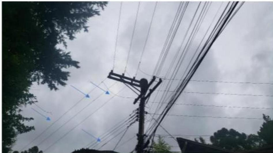
Emendas nos cabos de BT e MT. A proximidade da vegetação sugere sinais de ruptura devida à queda de galhos.
